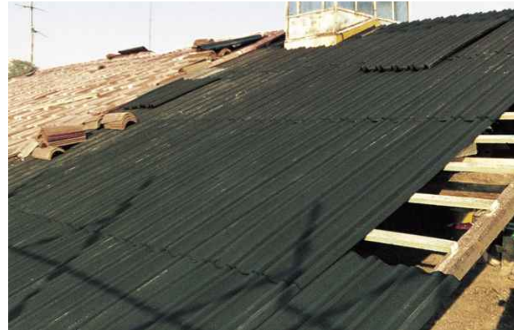
Aplicación de TEXSAPLACK en la Villa Reale de Monza.
