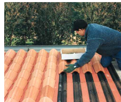
Colocación de Texsaplack BT canal sobre solera.
