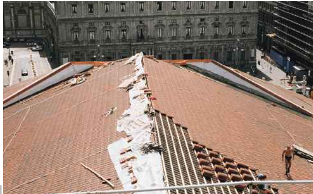
Colocación de Texsaplack® en el Teatro de la Scala de Milán.
